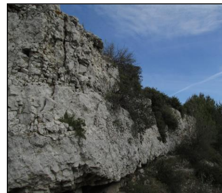
Zone de falaise à fissures –gîte ponctuel favorable aux chiroptères fissuricoles et rupestres C. GUIRAUD, 06/05/2014, Vitrolles (13)
