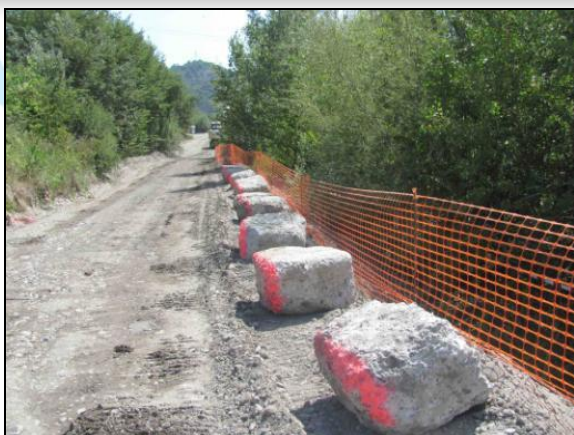
Exemple de dispositif prévenant la sortie accidentelle d'engins de la zone d'emprise
