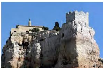
La Tour sarrasine en haut du rocher (Source: PLU 2013)
