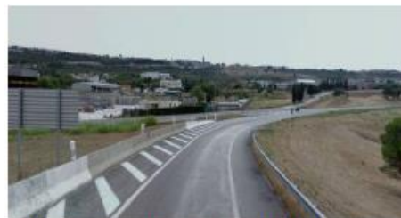
2/ Vue sur le site et son contexte depuis l'échangeur
