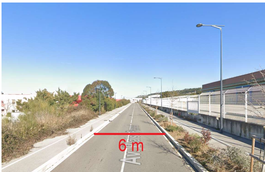
Figure 43 : Avenue Blaise Pascal (source : Google)
