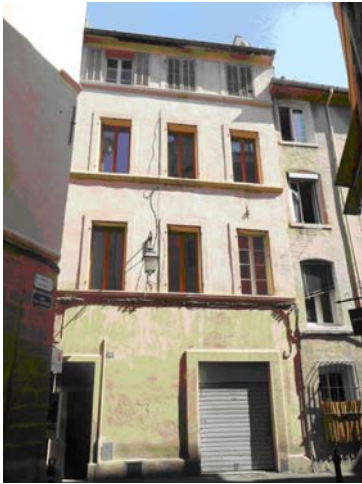
Façade rue Constantin
